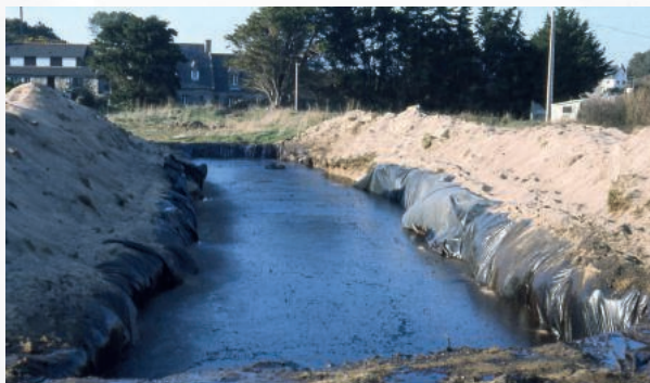
Fosse de stockage provisoire de déchets liquides d'hydrocarbures. Arch. dép. d'Ille-et-Vilaine, 2058 W 16.
